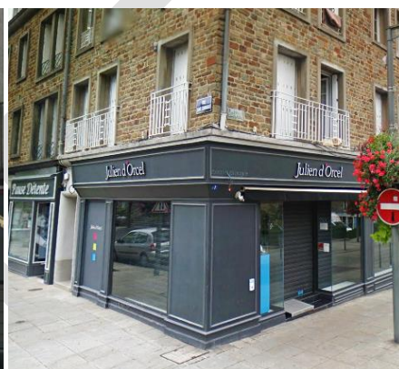
Enseignes sobres valorisant le bâti
