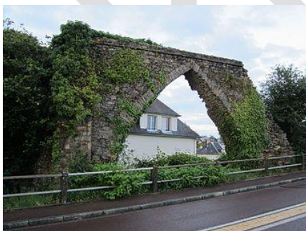
Ruines de l'aqueduc, site classé
