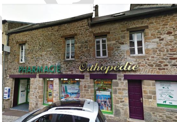
Enseigne en lettres découpées respectant la façade en pierre
