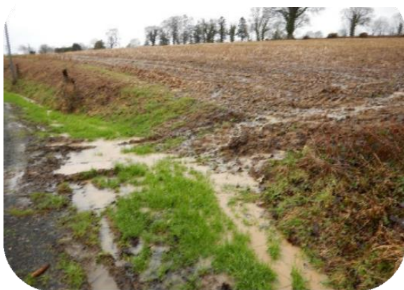
Photo SIAES Ruissellement AVANT TRAVAUX
