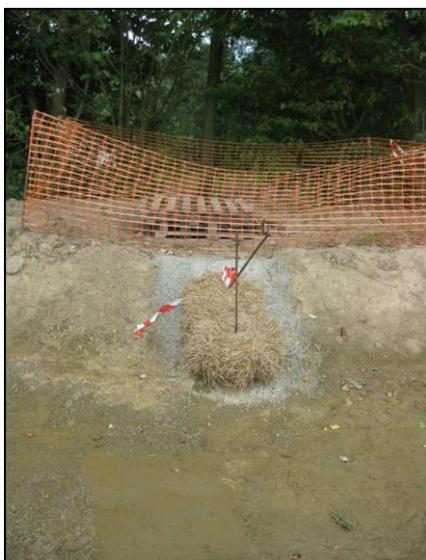
*Photo 1 : Emplacement du filtre à particules fines (botte de paille) pendant la phase des travaux au niveau du bassin d'orage*
